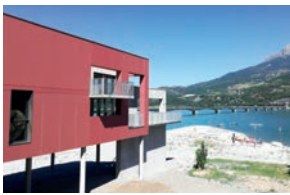
Projet architectural de la capitainerie de Savines-le- Lac (A. Levy – Syndicat mixte d'aménagement de Serre- Ponçon)
